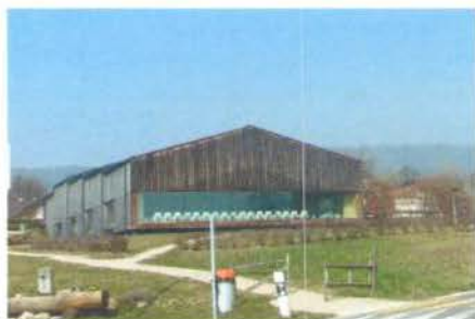
La piscine de Bassins
